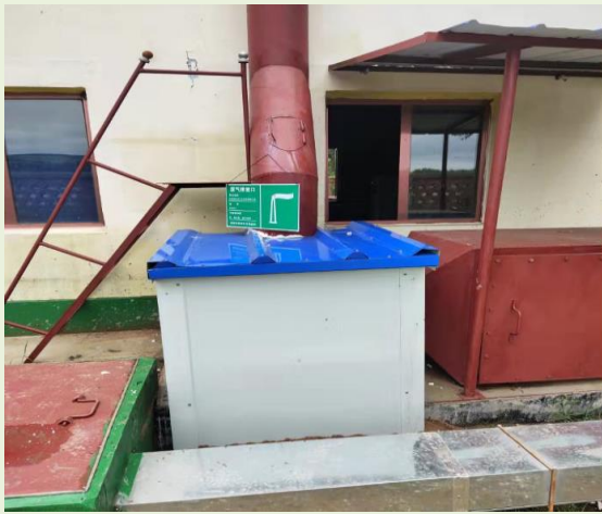
排气筒采样平台
