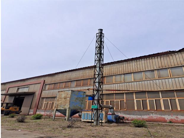
抛丸工序 15 米高排气筒（浇铸工序、落砂工序依托）
