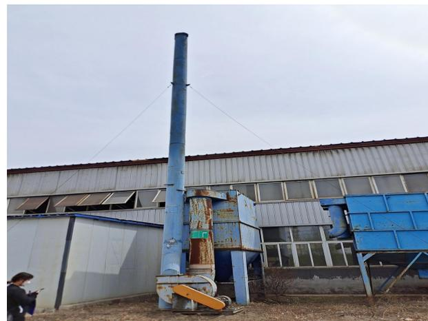
熔化工序布袋除尘器+15m 高排气筒
