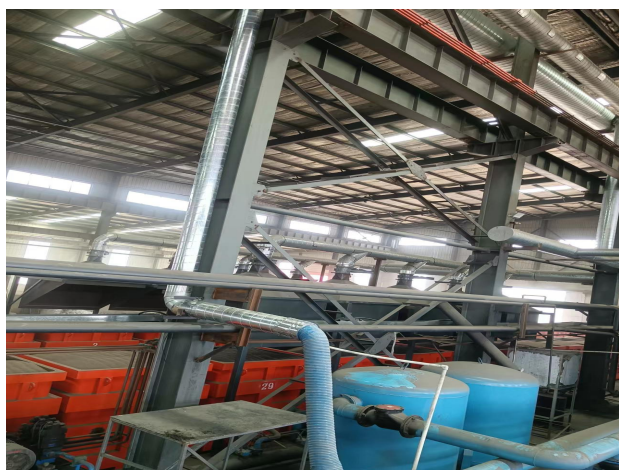
消失模真空负压浇筑工序管道 1
