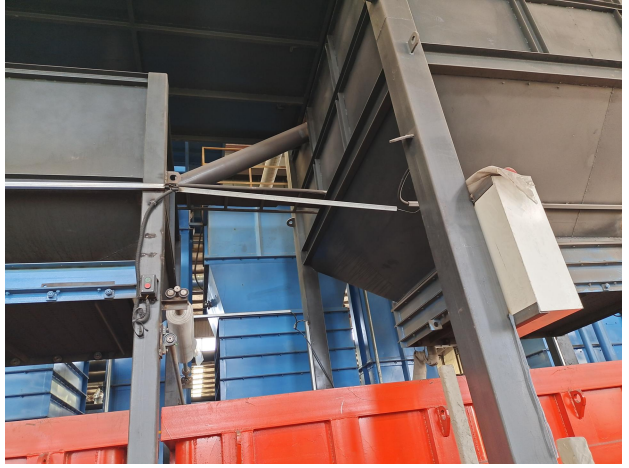
消失模铸造线造型、砂处理收集管道 1
