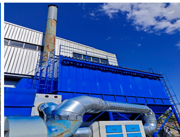
呋喃树脂砂浇铸+消失模真空负压浇筑 18m 高排气筒 (2#)
