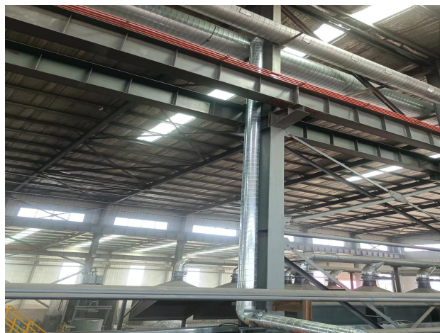
消失模真空负压浇筑工序管道 2
