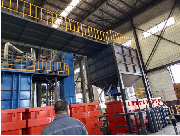
消失模铸造线造型、砂处理设备密闭 3
