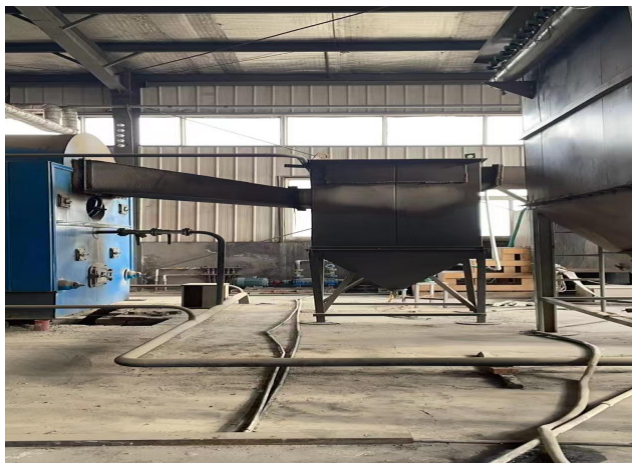
锅炉旋风除尘器
