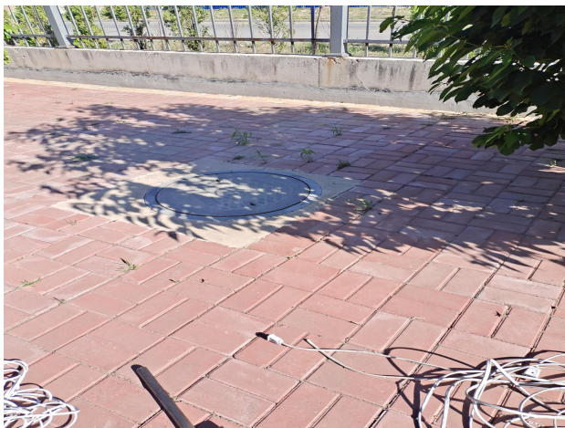
厂区废水总排口
