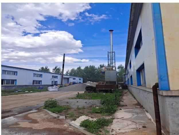
铸铁 2 车间混砂筛分、抛丸、人工打磨工序布袋除尘器+15m 高排气筒(6#)
