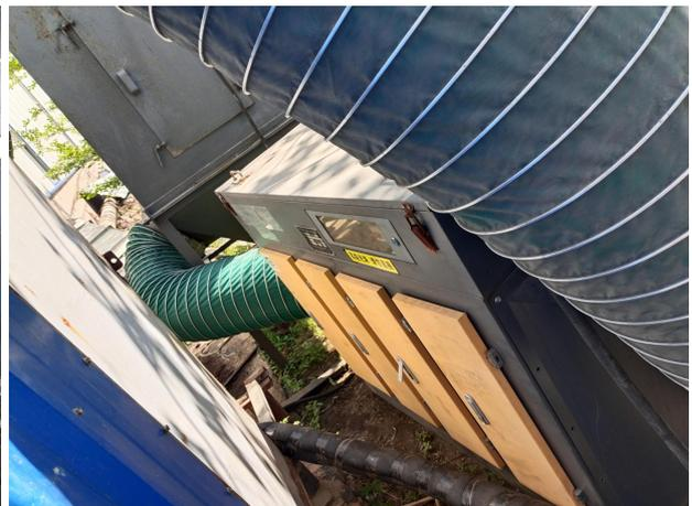
覆膜砂 1 车间熔化、浇铸工序 UV 光解装置+活性炭吸附装置
