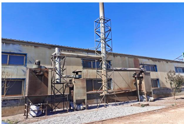
精密铸造车间抛丸工序布袋除尘器
