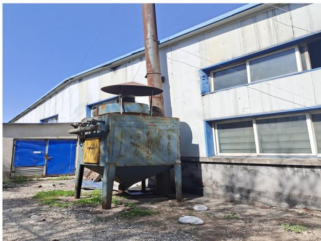
铸铁 1 车间熔化、浇铸工序布袋除尘器
