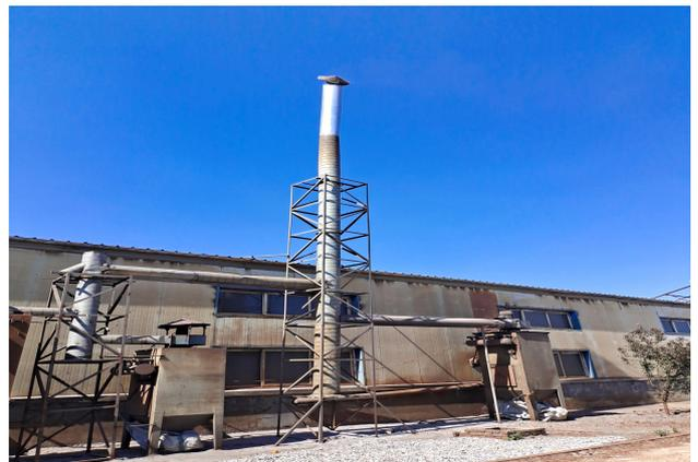
精密铸造车间抛丸工序 15m 高排气筒 (9#)
