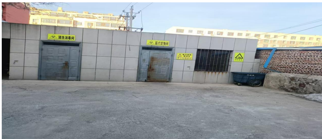
危废暂存间（依托彰武县人民医院危废暂存间）
