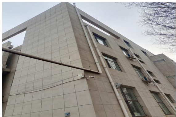
污水处理站 17m 排气筒
