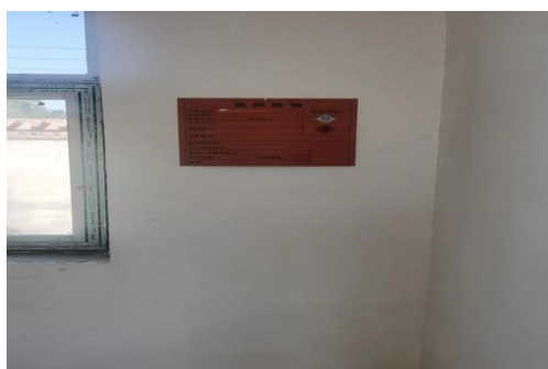
危废暂存间（内）
