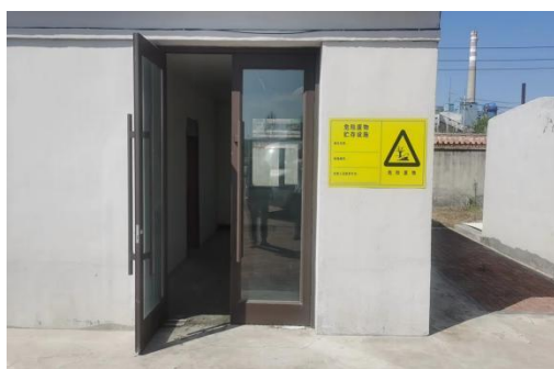
危废暂存间（外）
