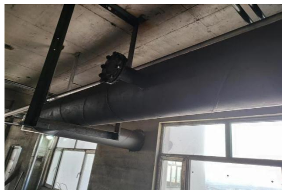
输煤转运站 30.2m 排气筒 (DA003)
