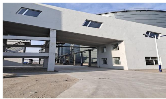
干灰封闭气力运输管道
