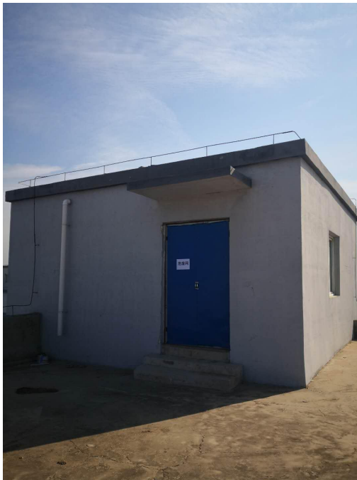
危险废物暂存间
